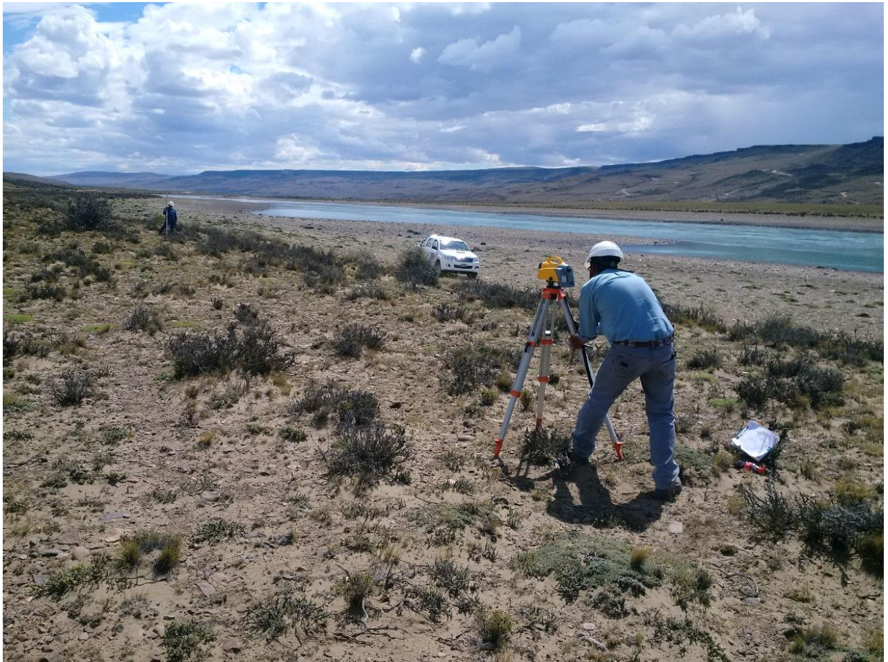
Figura 8 – Ejecución de Nivelación Geométrica Margen Derecha Río Santa Cruz JC
