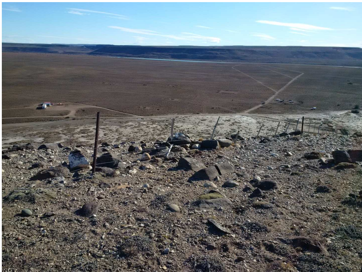
Figura 3 – Área Zona de Implantación de Obras Permanentes - Represa JC
